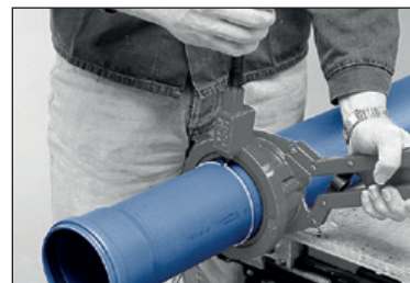
Kapning med kapnings- och fasningsapparat (FIGUR 16)
