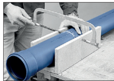
Kapning med fintandad såg (FIGUR 17)
