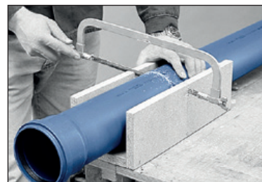
Kapning med fintandad såg (FIGUR 17)
