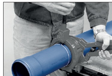
Kapning med kapnings- och fasningsapparat (FIGUR 16)
