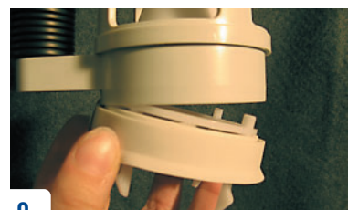
9 Bräddavlopp och manchettformad packning med korg ska användas. • Centra Duospol i bottenhålet. • Vänd blå volyminställningsreglage åt vänster.
