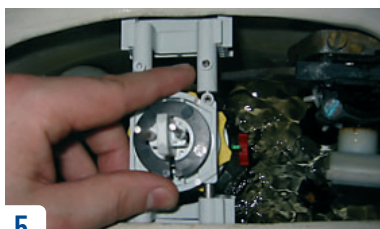
Täckbricka d=45 mm (behövs då det är tryckknapp)
