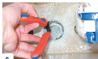
6 Klipp av muttern med en sidavbitare och tag bort den.
