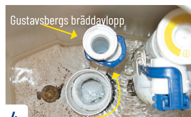
4 Lossa bottenventilsätet genom att dra och gånga det moturs tills bräddavloppet tar emot cisternkanten, tryck då neråt och vrid medurs. Upprepa tills muttern har släppt. Gå till bild 6. (Om inte muttern släpper, demontera cisternen eller se bild 5a-b.)
