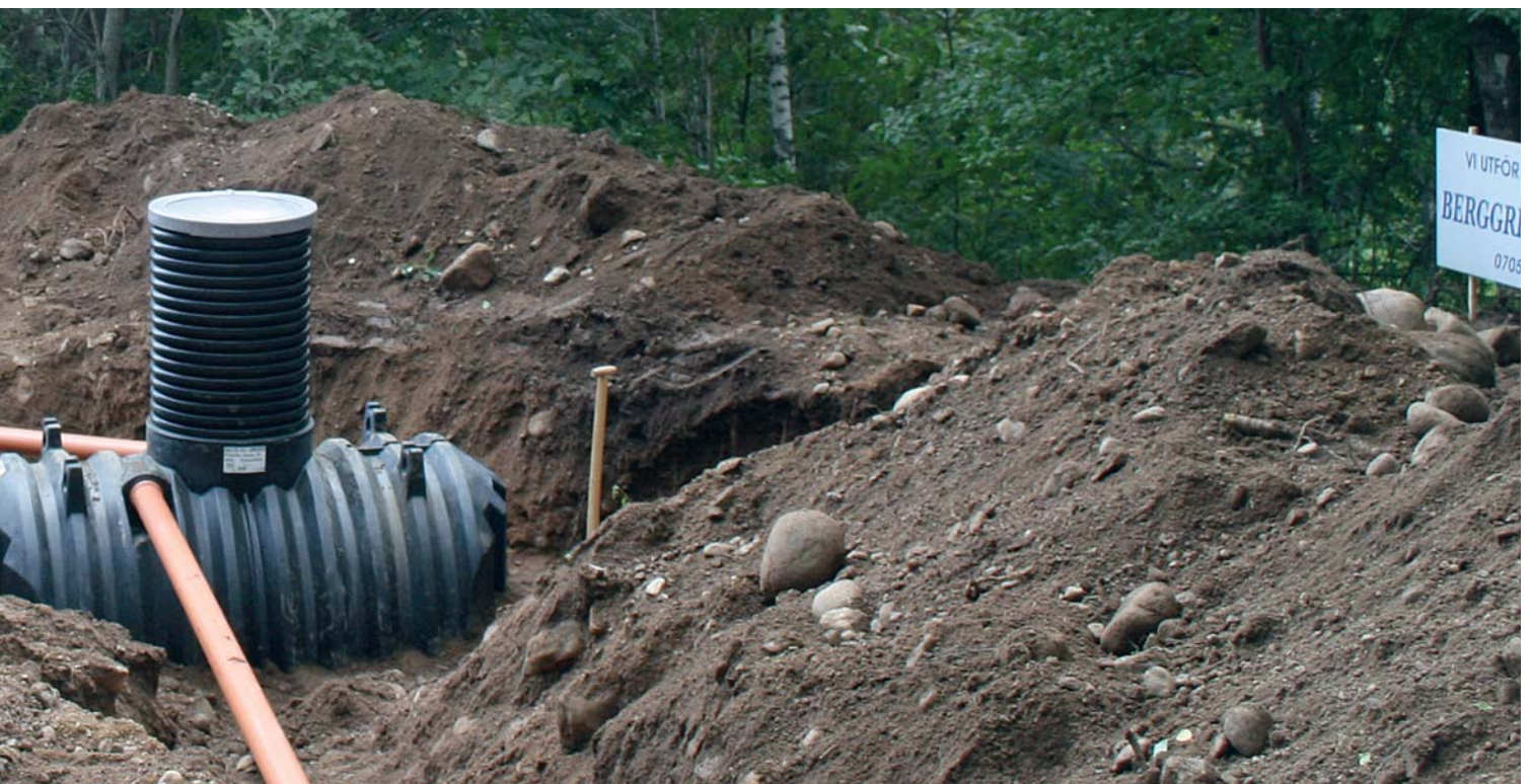
Septic III Compact infiltration med markbädd och kompletterande fosforering
