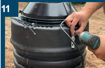
11 Skruva fast fästet till styrenheten.
