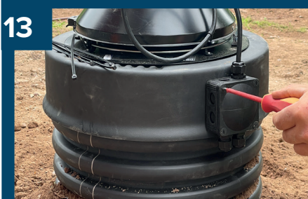
13 Skruva fast locket till styrenheten.
