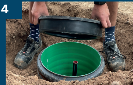
4 Tag bort befintlig förminskning.
