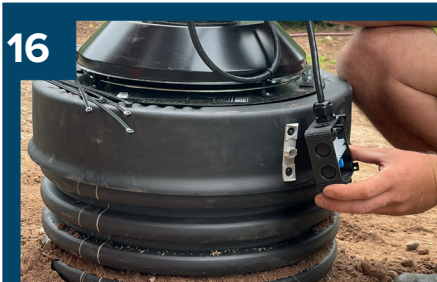
16 Skruva fast styrenhet.
