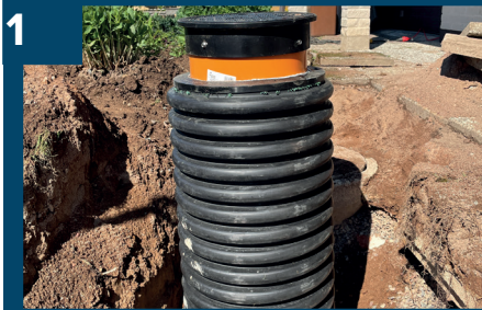
1 Gräv upp befintlig pumpbrunn.
