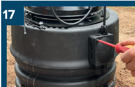
17 Öppna locket till styrenhet.
