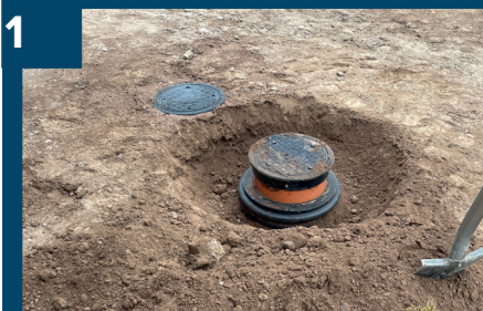
1 Gräv upp runt befintlig brunn.
