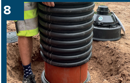
8 Skjut ner teleskopet i botten.
