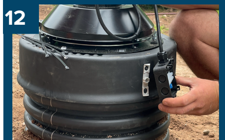
12 Skruva fast styrenhet.
