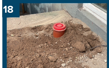
18 Montera ett godkänt tätt lock. Locket täcks med brunnsbetäckning.
