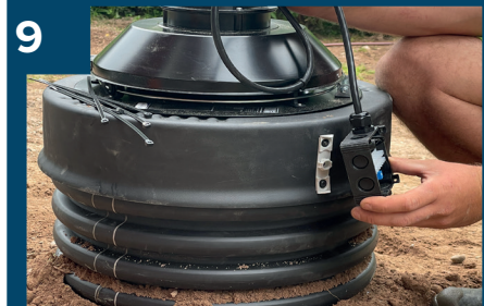
9 Skruva fast styrenhet.
