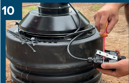
10 Tag loss fästet på styrenhet.
