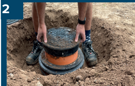
2 Lyft befintligt teleskopör.
