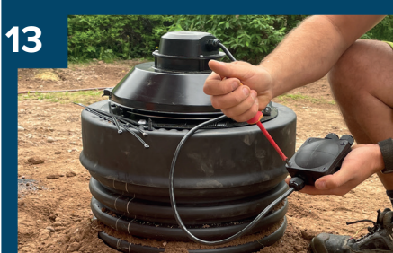
13 Öppna locket till styrenheten.
