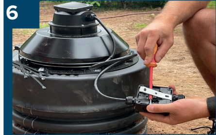
6 Tag loss fästet på styrenheten.
