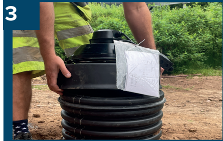
3 Montera lock med fläkt.
