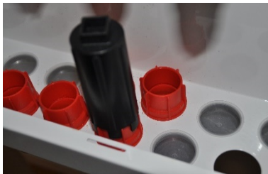
6. Skruva med handkraft och därefter med TECE Verktyg för skåpsmuff.
