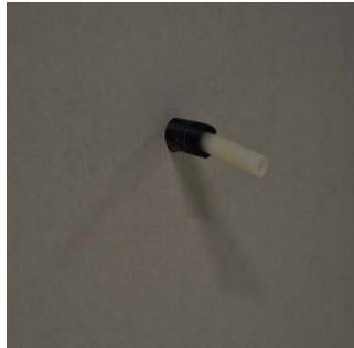
6 Borra ett 28 mm hål i byggskiva och montera den över röret.
