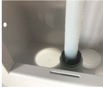
Ta bort röd skyddsplugg och tryck upp skyddsroret genom muff. Skyddsroret ska sluta i ovankant av muff.
