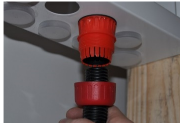
7. För på skyddsörsmuffen på skyddsroret och för in skyddsroret i skåpet.
