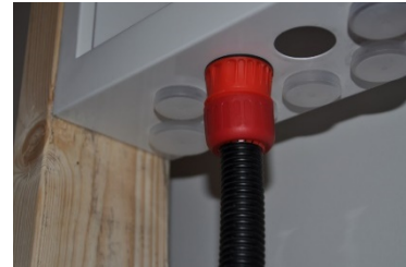
8. Skruva fast skyddsörsmuffen vilket säkerställer genomföringens hållfasthet.
