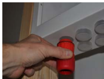
9. Dela dräneringsmuffen och för in genomföringsdonet i skåpet.
