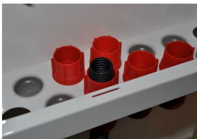
8. Skyddsroret ska sluta ovan den röda genomföringsmuffen.
