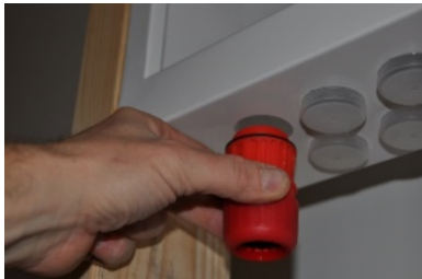
4b. Skåpsmuff 25/28mm. Lossa muffens dragsäkringshuv och för in genomföringsdonet genom skåpets hål i botten.
