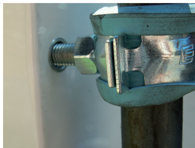
Närbild på infästning mot skåp.
