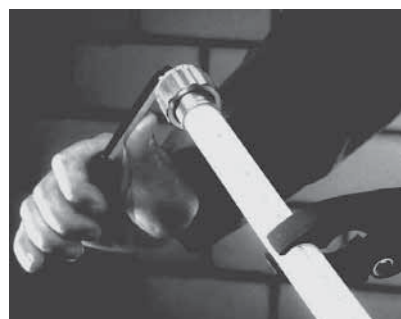
3.Skruva på kopplingen på röret till stopp. (medurs) Håll fast röret med tången.
