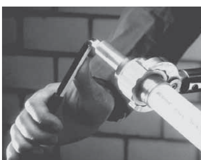
5.Dra åt verktyget med insexnyckeln tills du hör ett klick i momentnyckeln. Skruva sedan ut verktyget ur kopplingen.
