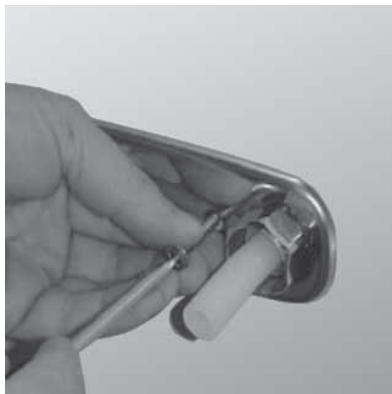
11. Blandarfäste eller väggbricka avsedd för PEX-rör 16 x 2,2 monteras enligt fabrikantens anvisningar.
