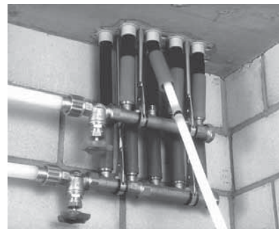
Nytt rör monterat på defekt (pkt.3)
