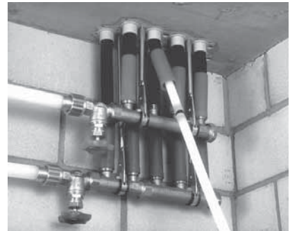
Nytt rör monterat på defekt (pkt.3)
