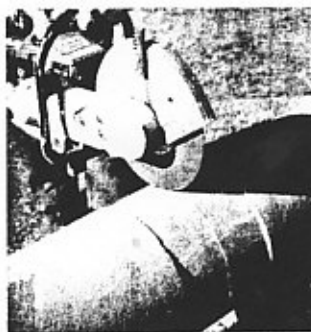
Kapning av rör
