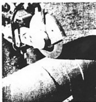
Kapning av rör
