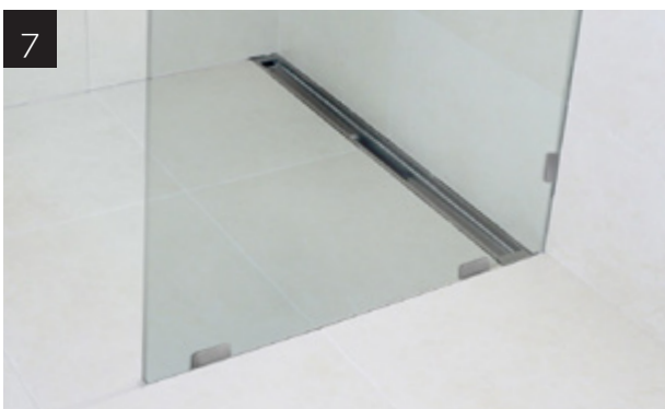
7 Slutligen monteras den valda duschväggen.
