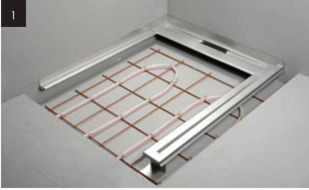
1 Avloppsarmaturen ShowerLine vägs in i rätt höjd och fixeras i vägg och bjälklag
