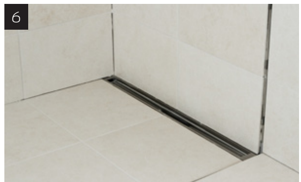
6 Stora golvplattor används med fördel. Snabbare montage och mindre fogningsarbete.
