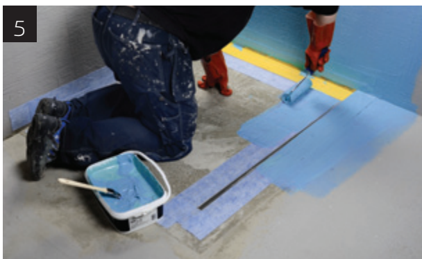
5 Tätskikt monteras på hela golvet och väggarna enligt tillverkarens anvisningar. Lagg vald Unidrain ram, ClassicLine eller HighLine på plats innan väggplattorna monteras.
