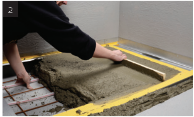
2 Avjämningsmassan eller betongen läggs på i duschplatsen. Avloppsarmaturens inbyggda fall tillsammans med en rätbräda underlättar fallbyggnaden. Därefter kan resten av golvet gjutas upp i nivå med avloppsarmaturens horisontella tätskiktsfläns. Ytor för tätskikt skyddas med lämplig bygg / skyddstape.
