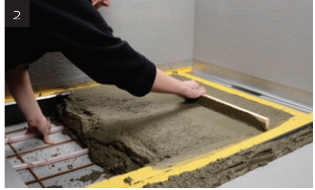
2 Avjämningsmassan eller betongen läggs på i duschplatsen. Avloppsarmaturens inbyggda fall tillsammans med en rätbräda underlättar fallbyggnaden. Därefter kan resten av golvet gjutas upp i nivå med avloppsarmaturens horisontella tätskiktsfläns. Ytor för tätskikt skyddas med lämplig bygg / skyddstape.
