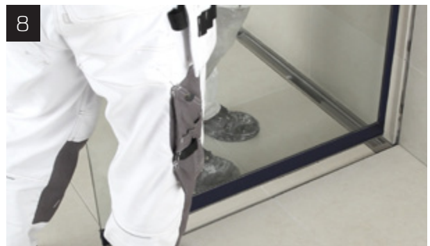
8 Unidrain GlassLine monteras i profilen på vägg och i spåret på ShowerLine armaturen.
