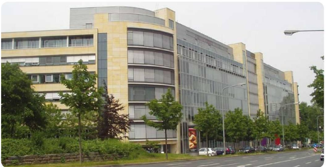
Referensobjekt Kontorsfastighet, Frankfurt a.M. Tyskland.
