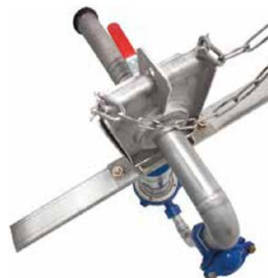
Pump med monterad gejderutrustning monterad inuti pumpstationen.
