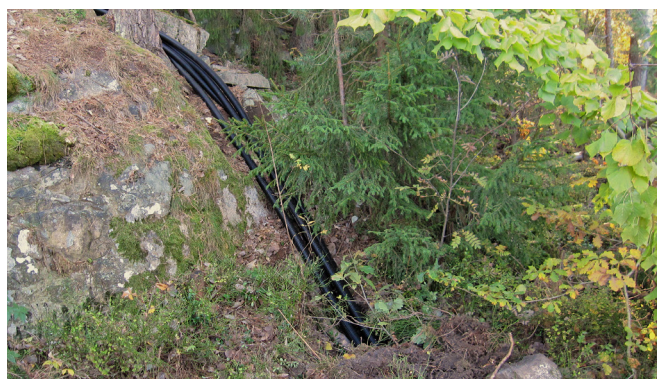
Supra-rör kan vid behov installeras ovan mark.
