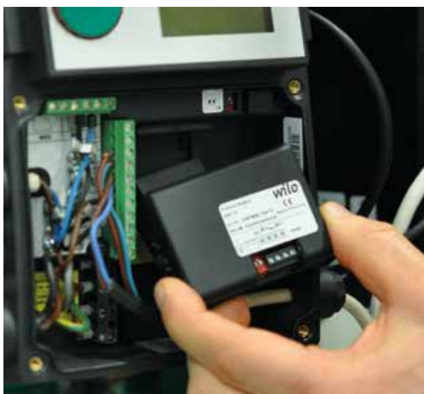
Tvillingpump Wilo-DP-E med påmonterade IF-moduler för central övervakning via överordnat automationssystem.
