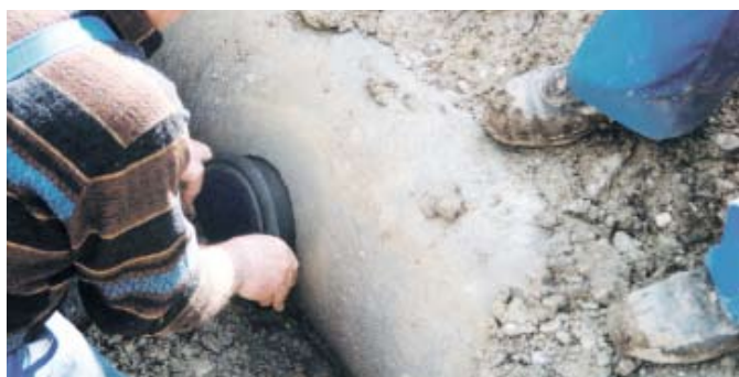
AWADOCK anslutningstätning förs in i borrhålet
