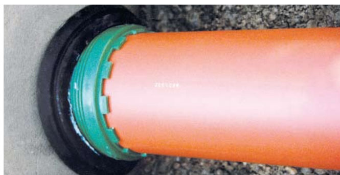
Röret stoppas in i AWADOCK skruvkrona intill anslaget
