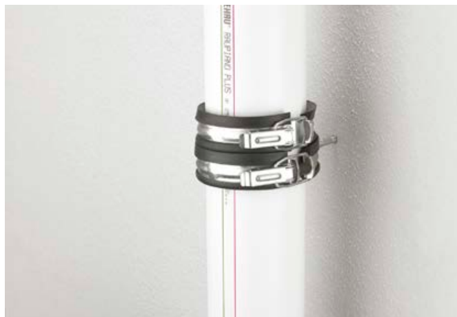
Fullständigt installerad klammer.
