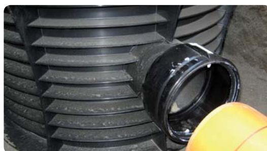
Montering av rör
