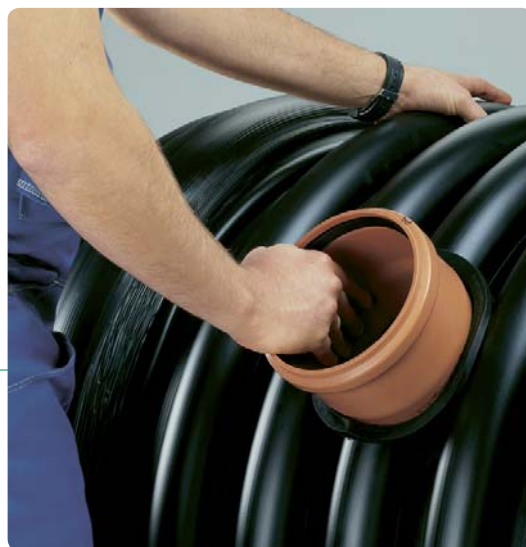
4. Montera anslutningsröret.
