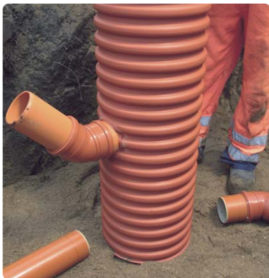
2. Brunnen placeras på rätt djup och på en riktigt utförd rörgravsbotten.
