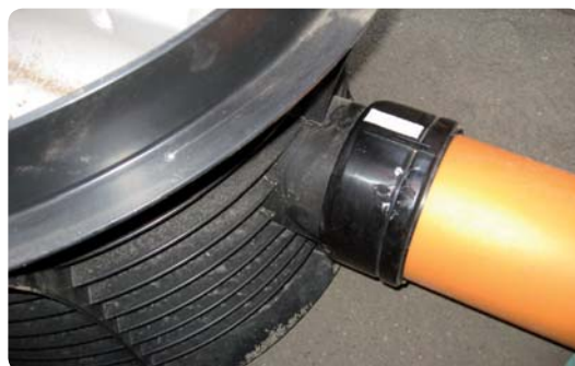
Rör monterat i muffen
