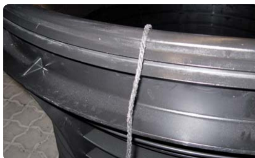
Använd emballageband för att undvika luftfickor
