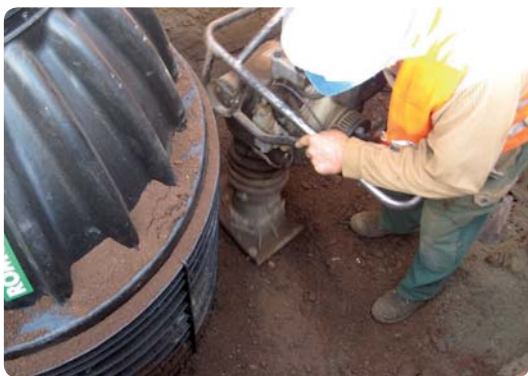
Komprimering med maskin
