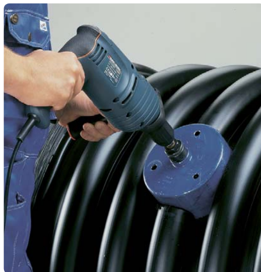
1. Borrning för anslutningen görs med hjälp av en hålsåg.
