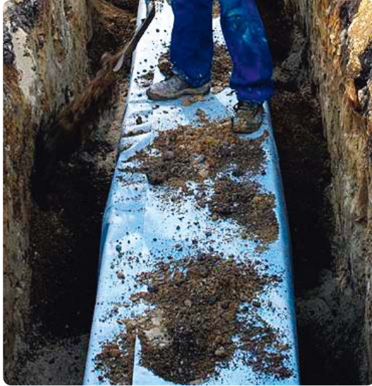
5. Kringfyllningen av ett månggraderat material förs på jämt runt magasinets alla sidor och packas i jämna lager.
