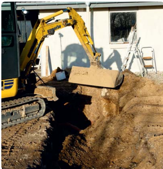
6. Resterande fyllningen över magasinet skall utföras enligt AMA Anläggning 07 efter vad konstruktionen kräver.
