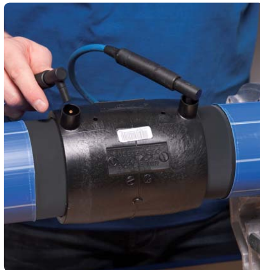
6. Montera svetskablarna, och muffen är klar för svetsning.
