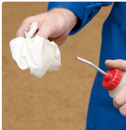
4. Använd godkänd rengöringsvätska och torka av röret före svetsning.
