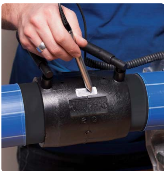
7. Avläs svetsdata med hjälp av streckkodssystemet.
