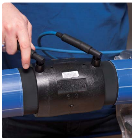
8. Därefter utförs elektrosvetsning.
