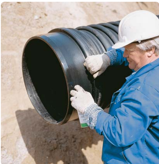
3. Stryk smörjmedel på rörets spetsända.
