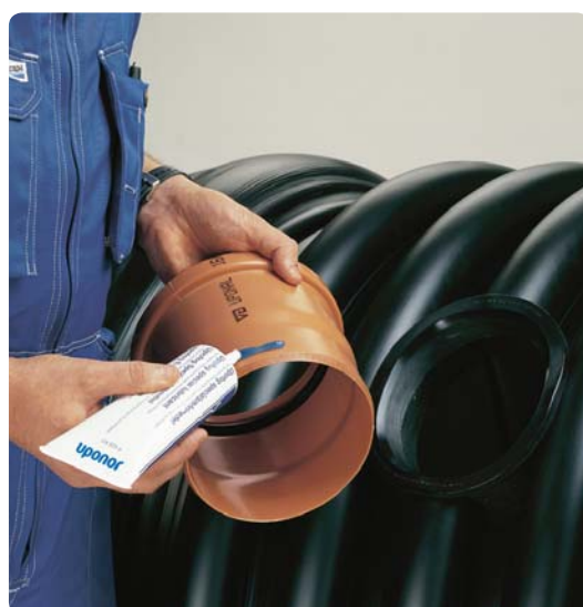
3. Stryk smörjmedel på anslutningsrörets spetsända
