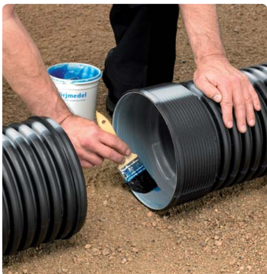
3. Muffen smörjs invändigt med smörjmedel.
