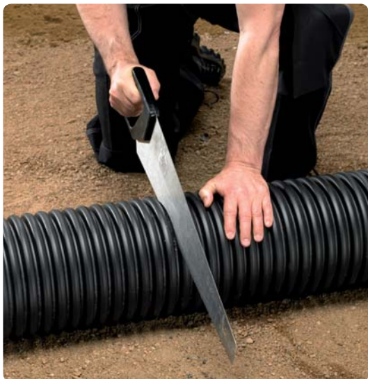
1. Rörret sågas av mellan 2 ribbor med fogsvans.
