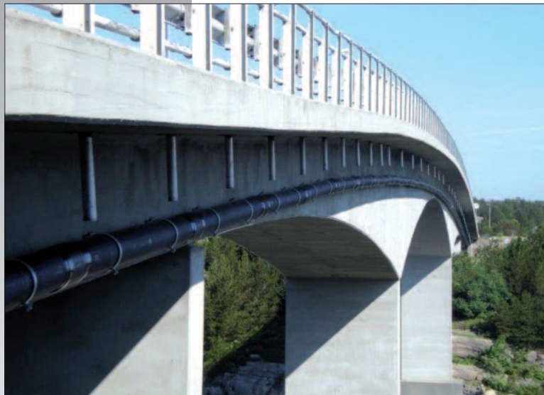
Ulvesund i Øygarden Isovarm rörledning
