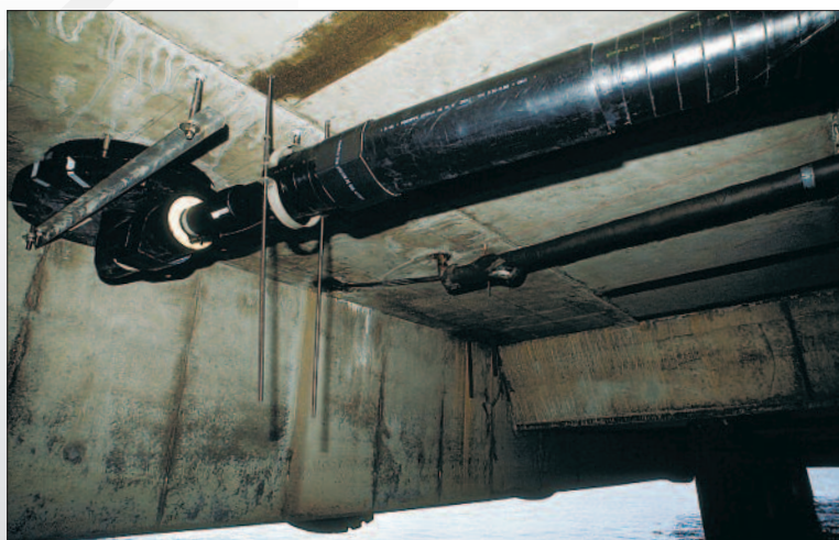
Vestfold, motorvägsbro med Isovarm dagvattenledning
