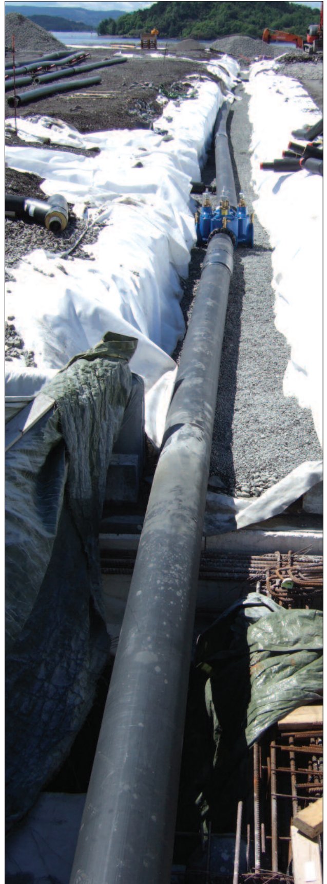
Isovarm som både vatten og avloppsledning for større projekt på Særenga i Oslo
