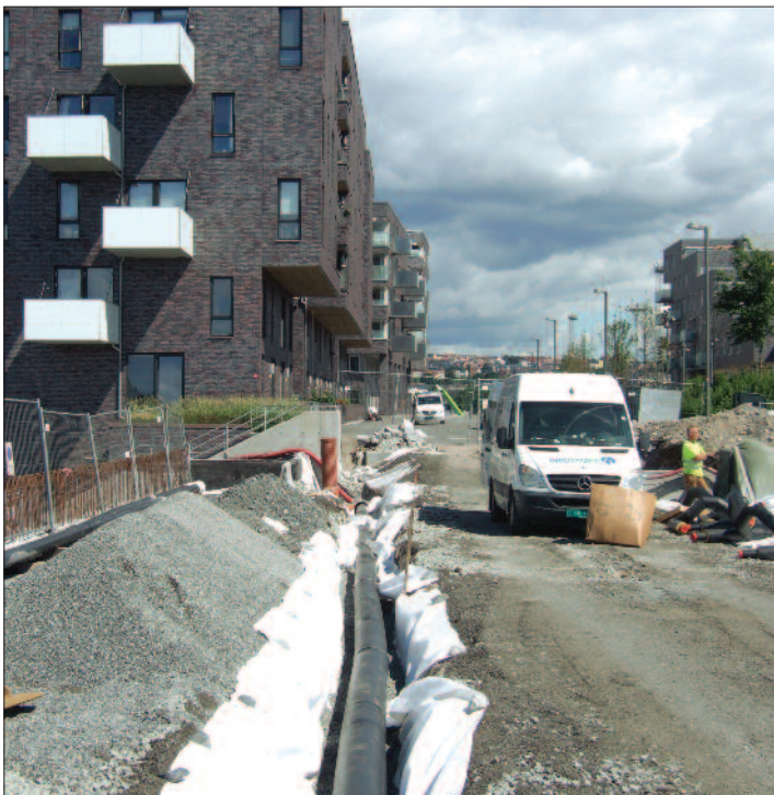
Isovarm som både vatten og avloppsledning for større projekt på Særenga i Oslo
