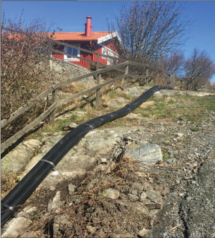
Exempel på Isoterm vatten och tryckavlopp i grunda schakter: Alnö, Sundsvall
