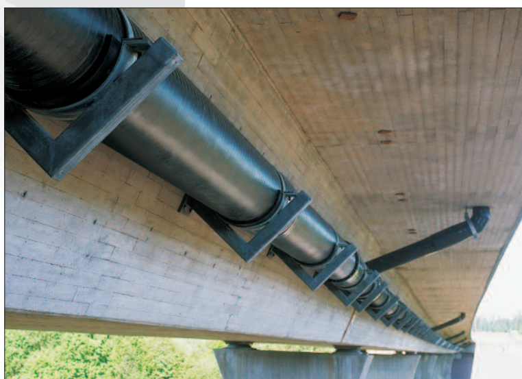
Vestfold, motorvägsbro med Isovarm dagvattenledning
