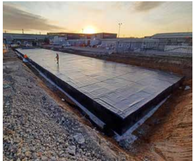
Installation med membran-tätt magasin
