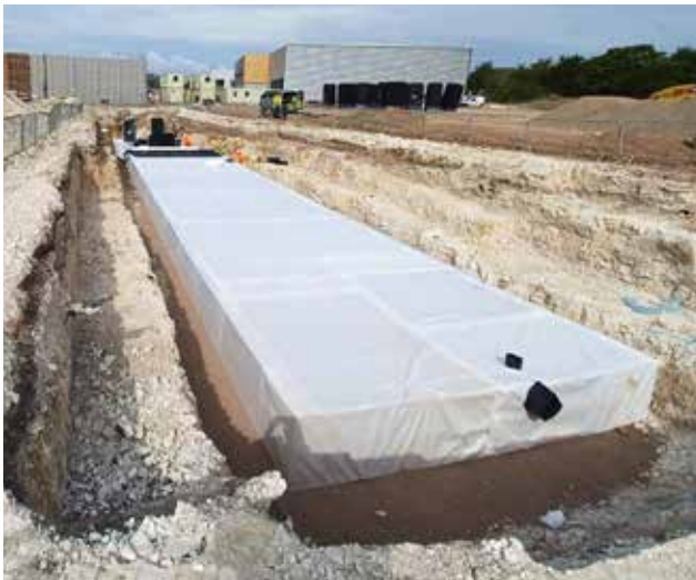
Installation med geotextil-infiltration
