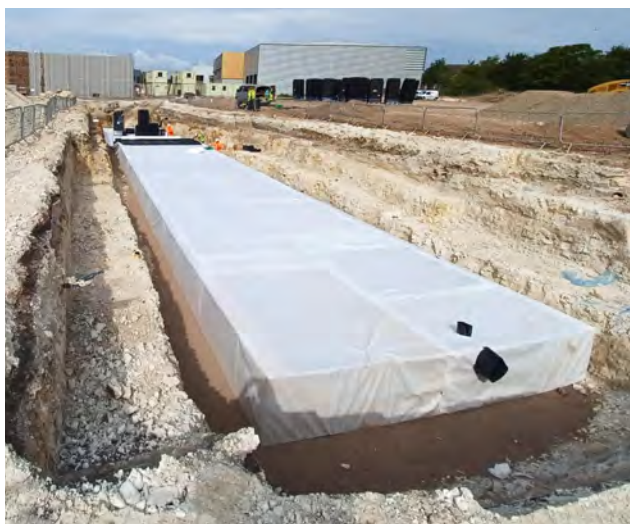
Installation med geotextil-infiltration
