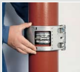
3. Se till att kopplingens bult är fri och tryck till bultarna på kragen.
