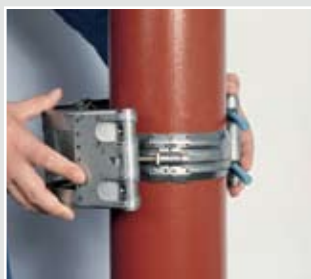
2. Kragen öppnas helt och placeras över rörsammanföringen.
