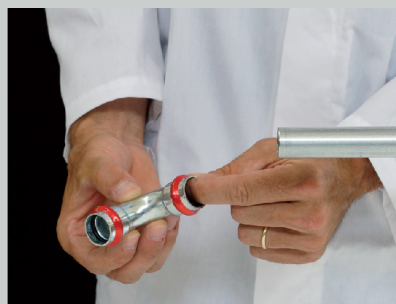
Figur 23 Kontrollera förekomsten och placeringen av o-ringar
