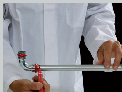
Figur 24 Sätta i rör i kopplingar och markera rätt position
