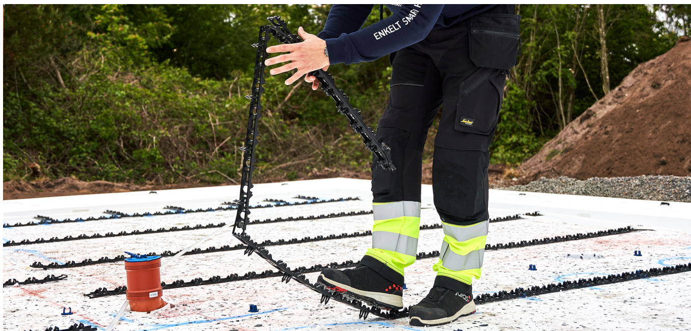
VVS-montören vecklar ut och lägger ner listen på EPS-isoleringen.
