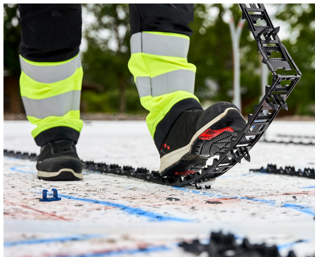
LK Golvvärmelist Combi 16/20 på EPS-isolering.
