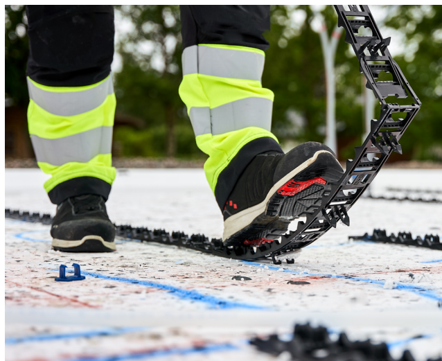
LK Golvvärmelist Combi 16/20 på EPS-isolering.
